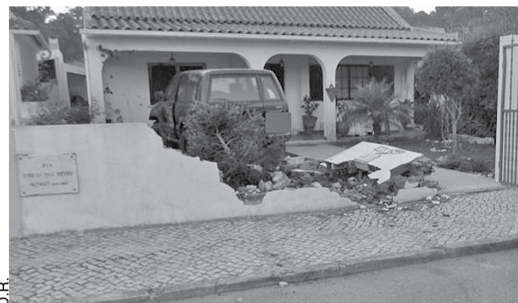
Jipe derrubou muro de uma moradia, e matou a proprietária
